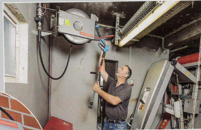
Kurz am Schlauch ziehen, die Pistole drücken – und einfach mit dem Reinigen loslegen: Nach Jahren der Improvisation genießt Norbert Tombergs sichtlich den neuen Komfort.
