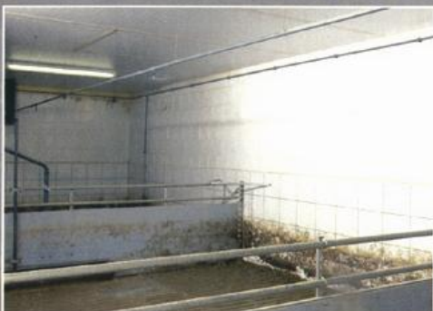
Pro Buchtenreihe eine Düsenleitung mit je einer Düse pro Bucht ist das Planungsziel von Meier-Brakenberg.
