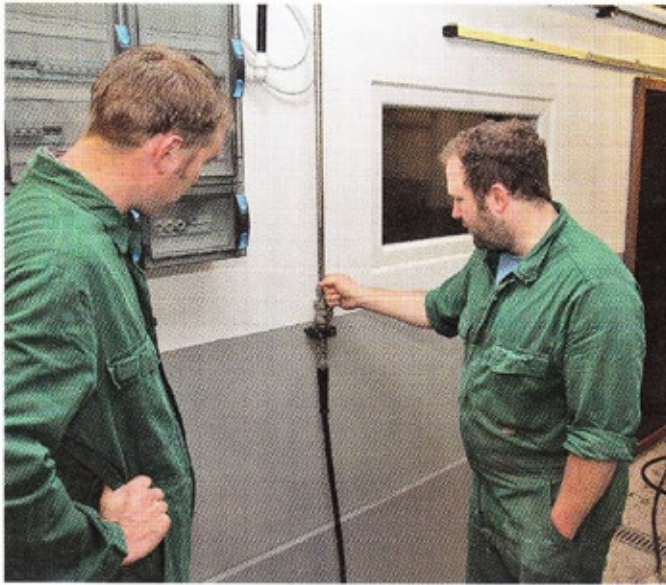
Bequemer geht's nicht: Der Gummischlauch des Hochdruckreinigers wird vor dem Abteil an die Zentraleitung angeschlossen.
