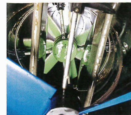
Der gleiche Kanal nach der Reinigung mit dem Schachtwäscher.
