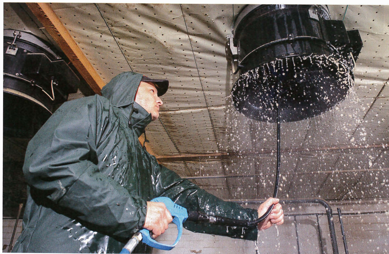
Durch den Wasserdruck klettert der Schachtwäscher von allein im Kanal hoch, der Kraftaufwand ist gleich null. Stellt man sich leicht seitlich neben den Abluftschacht, bleibt man von der „Schmutzduche“ größtenteils verschont.
